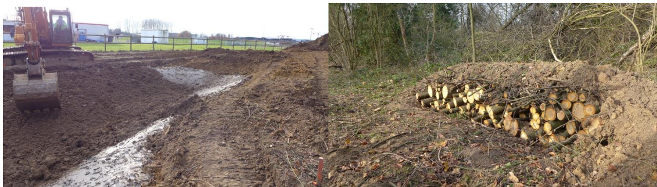
Figure 1 : Remise en place de la terre végétale sur le corroi d'argile (en gris) et abri à triton (Mare 8.1)
