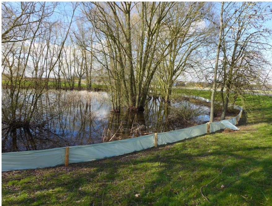
Figure 8 Dispositif en place sur la mare du rondpoint
